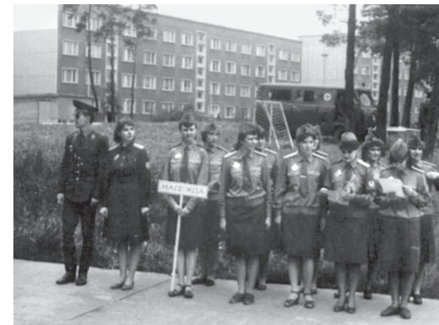
Ab 1967 errichteten die Sowjets 16 Bauten für Offiziersfamilien. Das Foto aus den 1980er Jahren zeigt sowjetische Soldatenfrauen vor diesen Gebäuden im Olympischen Dorf.
