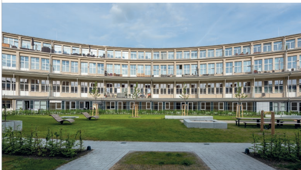
Insgesamt 115 Wohnungen umfasst das Speisehaus der Nationen im ersten Bauabschnitt der G.O.L.D®. Haus Central und die Neubauten im Inneren und Grünen Ring ergänzen das Denkmal.
